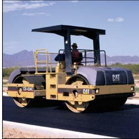
Figura 3. Compactación Mezcla Asfáltica
