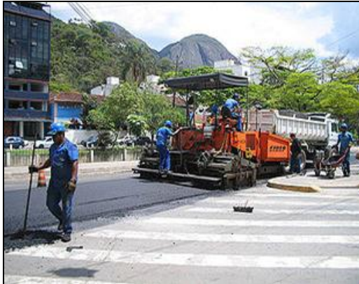
Figura 2. Aplicación de Mezcla Asfáltica
