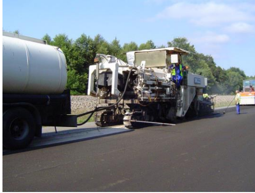
Figura 6. Extendido de la mezcla reciclada
