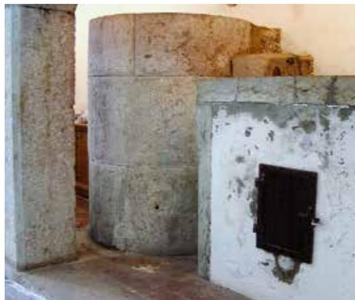
◀ Casa do Alambique. Vista geral da fornalha, à esquerda, onde se apoiava a caldeira do alambique e da estrutura de arrefecimento, à direita, que alojava a sua serpentina
