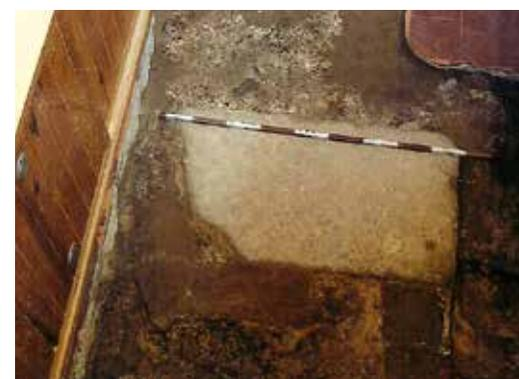
▲ Casa do Alambique. Rebaixamento do piso atual na área adjacente à estrutura de arrefecimento, notando-se a existência de uma laje, associada a tijoleiras e argamassas, que constituíam o solo primitivo naquele sector do edifício
