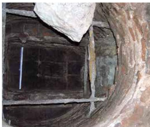
▲ Casa do Alambique. Vista do interior da fornalha depois de completamente esvaziada dos entulhos que a preenchiam. Note-se o fundo da fornalha, forrado de tijoleiras fortemente escurecidas pelo calor
