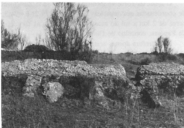
Foto 2 — Açude da Torre Vã. Vista de jusante.
