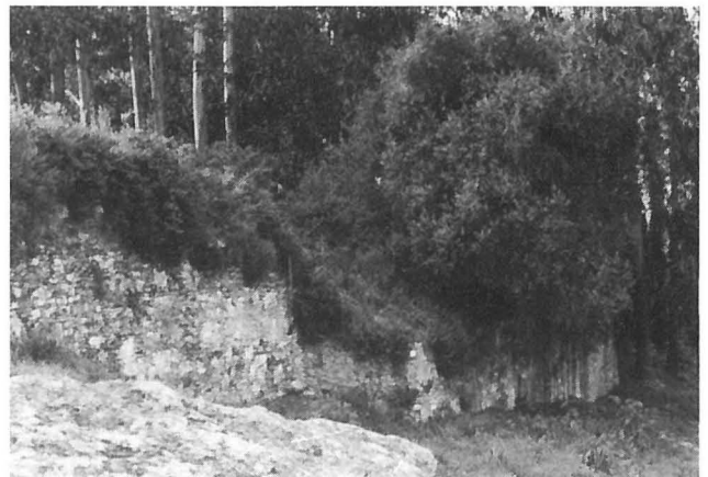
Foto 6 — Barragem da Mandorelha de Cima. Vista de jusante.
