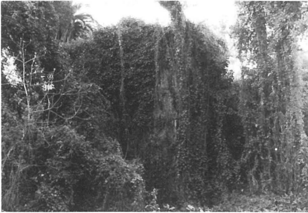
Foto 4 — Barragem da Mandorelha de Baixo. Vista do edifício da azenha, coberto por hera.
