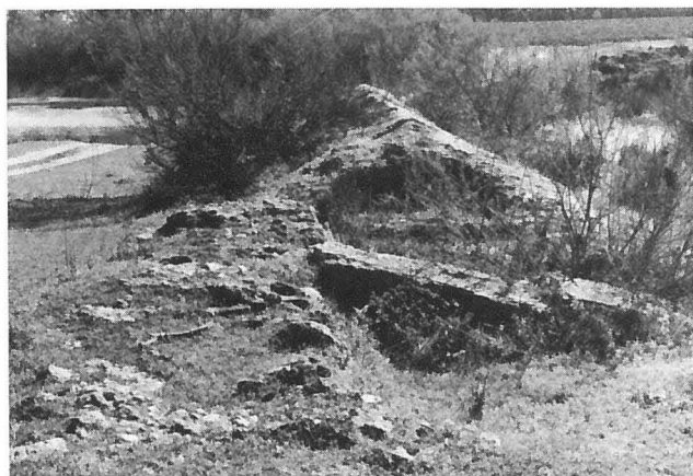
Foto 1 — Açude da Torre Vã. Vista da zona do provável edifício de moinhos (primeiro plano) e do troço do açude.
