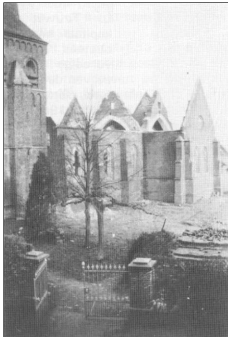
Fig. 12 : De verbouwingswerken in 1901 aan de Sint-Monulfus en -Gondulfuskerk 26 .
