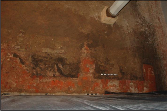
FIG. 16: Zicht op de bakstenenfunderingen: sporen, S1, S2 en S3.
