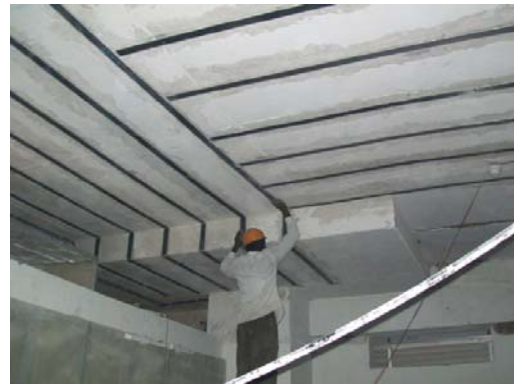
(d) NSM-FRP strengthening of bridge deck
