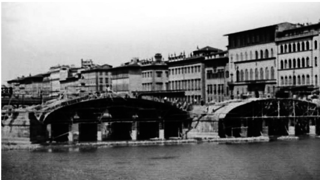
Figura 23 - I lavori di ricostruzione del Ponte Santa Trinita.
