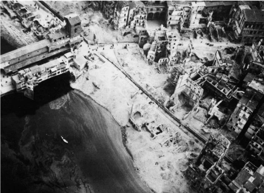
Figura 21 - La decisione di Hitler (o, più verosimilmente, di Kesserling) di non distruggere il Ponte Vecchio, comportò il fatto che tutti gli edifici adiacenti furono rasi al suolo.
