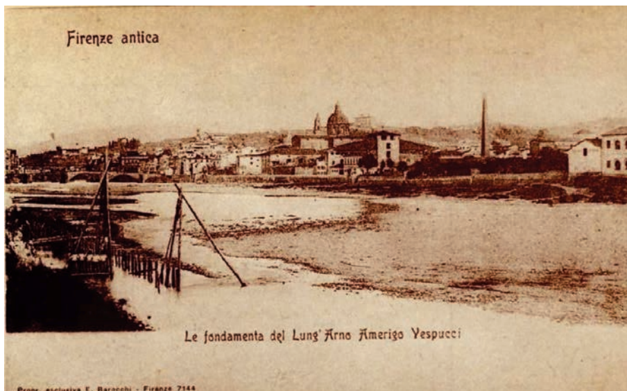
Figura 19 - Lavori di realizzazione del Lungarno Vespucci.
