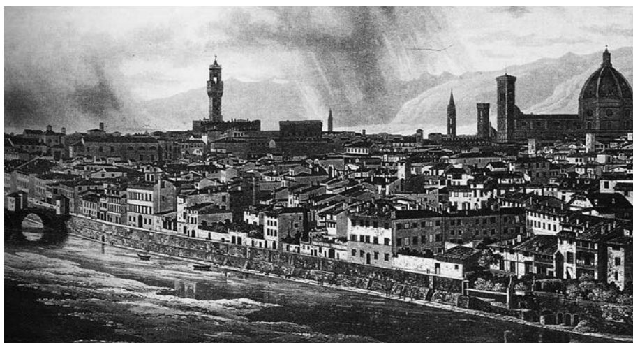
Figura 13 - Il Lungarno alle Grazie nella sua configurazione originale risalente al 1287, in una incisione realizzata poco prima dei lavori per l'ingrandimento di Firenze progettati da Giuseppe Poggi. Si nota uno dei primi esempi a livello europeo, di difesa idraulica con "muraglioni".
