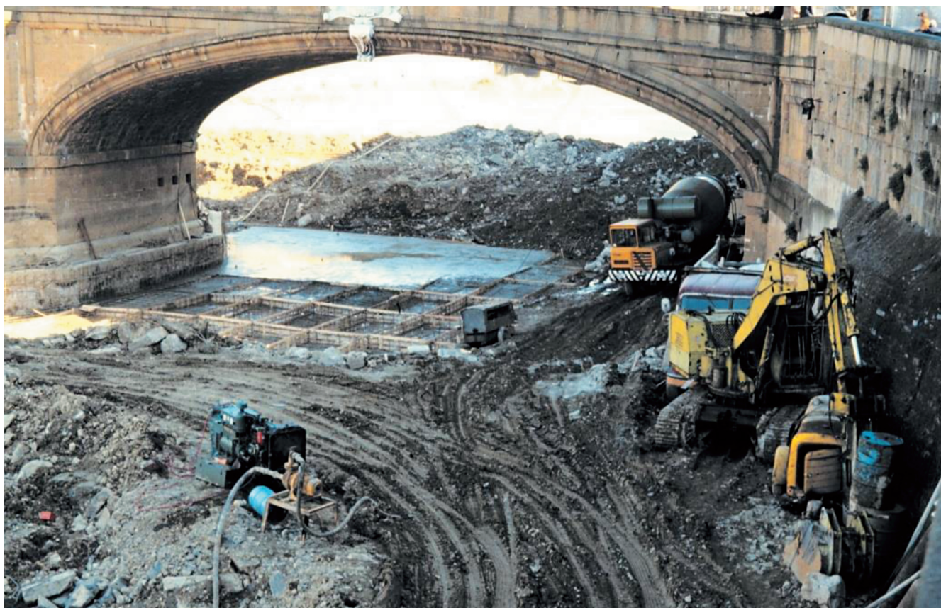
Figura 25 - Una rara immagine dei lavori per l'abbassamento delle platee del ponte Santa Trinita. Si nota la predisposizione delle casseforme per il getto. Il livello originale dell'alveo coincide con la base della pila del ponte in pietra arenaria.
