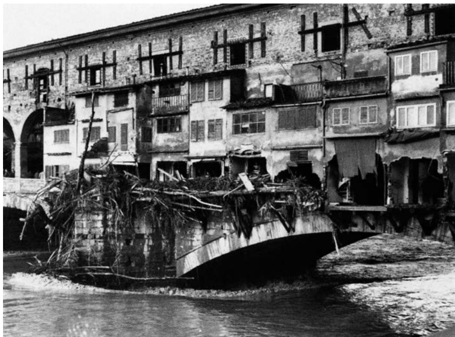
Figura 6 - L'impatto del materiale solido flottante sulla struttura e la sovrastruttura del Ponte Vecchio a seguito dell'evento del 1966
