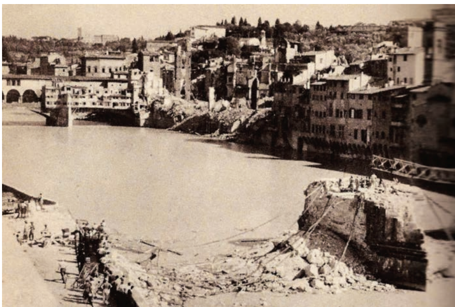
Figura 22 - I lavori di predisposizione di una passerella Bailey che poggia sulle pile del Ponte "A Santa Trinita" nel settembre del 1944. Sullo sfondo campeggia la distruzione degli edifici di Borgo Sant'Jacopo.
