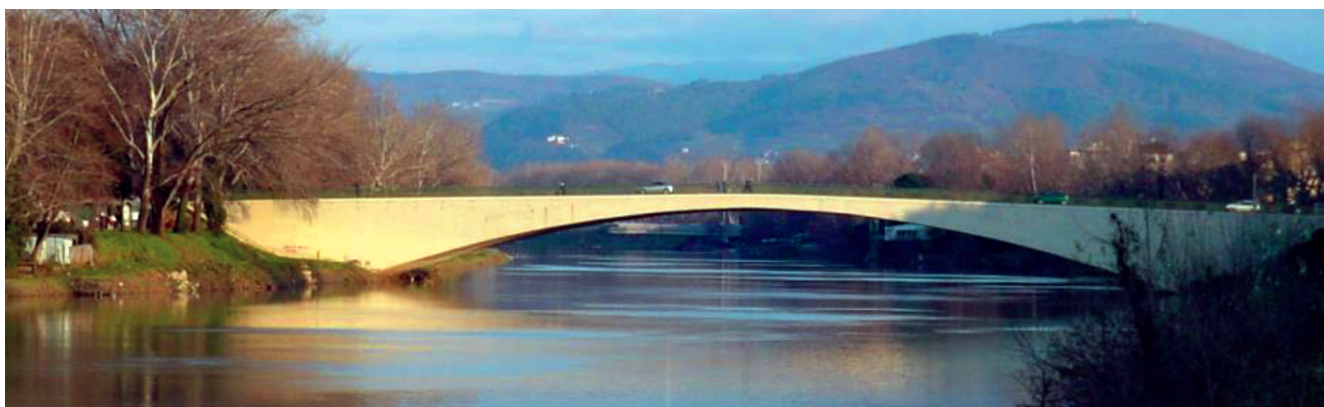
Figura 16 - Vista da valle del Ponte San Niccolò, che segna l'inizio del tronco dell'Arno nel centro storico. È evidente la struttura evidentemente tozza e la conseguente riduzione operata alla sezione.
