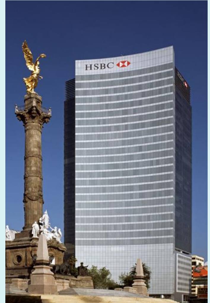
Torre HSBC/ Cd. de México.- Edificio inteligente con certificación LEED
