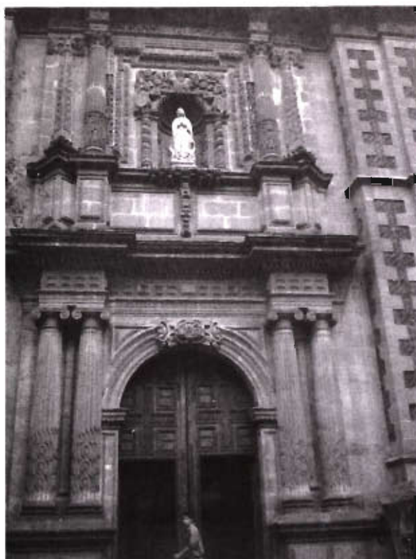
Edificio en el Centro Histórico, ciudad de México, en el extremo izquierdo es evidente la rafa.
