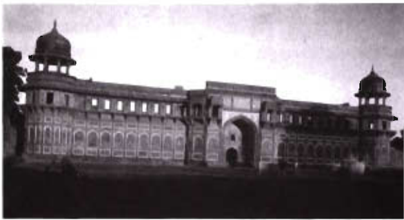
Figura 8. Jahangiri Mahal en el Fuerte de Agra (1560-1570). Fachada Oeste. Fuente: Ebba Koch, Mughal Architecture . Prestel-Verlag, Munich, 1991.
