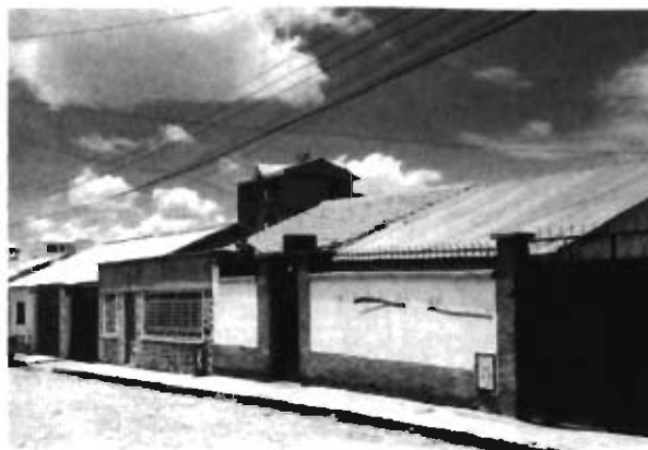
Figura 11. Casas originales (Foto: Ana Meléndez).
