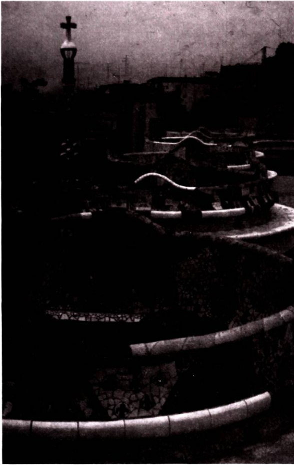
Figura 15. El banco serpenteante del Parque Güell (Antonio Gaudí, 1900-1914) forma el límite de la plaza-mirador, creando un elemento que brinda, a la vez, protección y descanso. Está recubierto con “trencadis” —“trencar” quiere decir “romper” en catalán—, tipo de recubrimiento utilizado por Gaudí en varias de sus obras, hecho con pedazos rotos de loza cerámica policromada.
