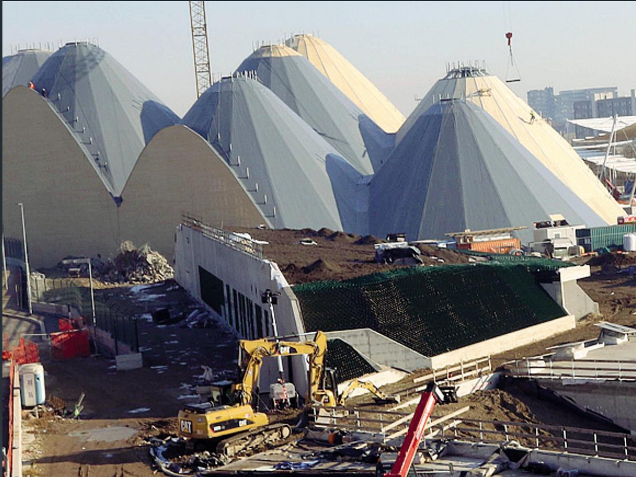
Desmantelamiento de Pabellones
