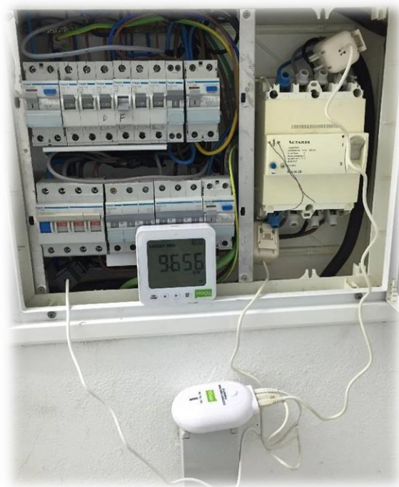
Figura 3: Ligações do aparelho para medição do consumo.
