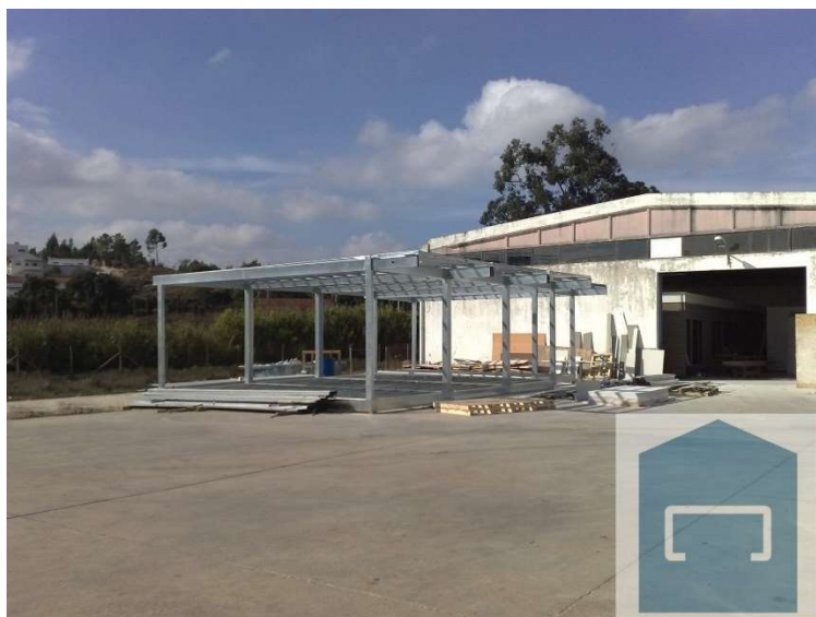
Figura 2.15 – Montagem da estrutura em fábrica (Fonte: Futureng.pt, Construção modular, Visitado em 28.10.2016)
