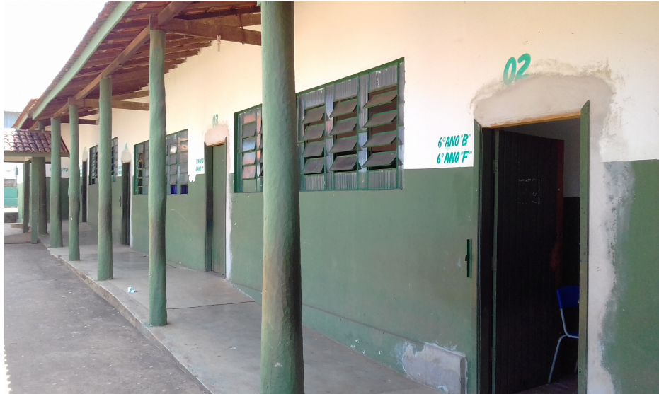
Figura 10 - Salas de aulas
