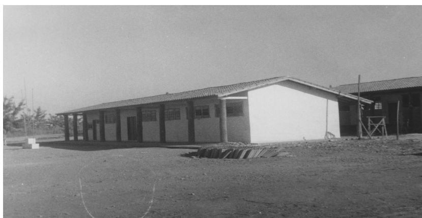
Figura 4 - Escola Therezinha Abreu Vita – fase de construção, em 1983.
