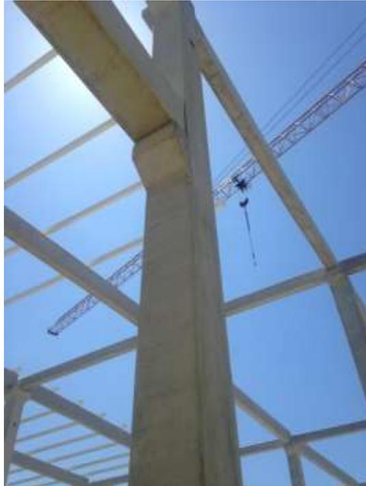
Figura 4.9 – Pilar pré-fabricado estudado
