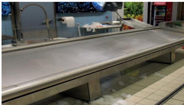
Figura 12 – Banca de exposição para peixaria, com sistema de degelo automático.
