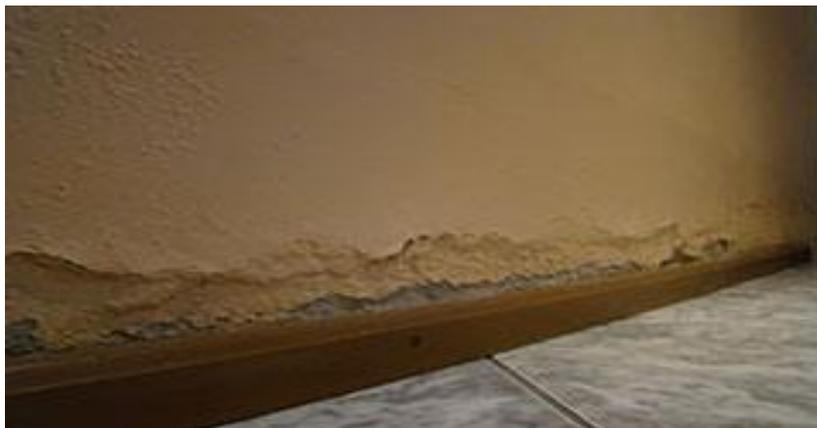
**Figura 36** - Criptoflorescência em paredes (Ecolust, 2015)
