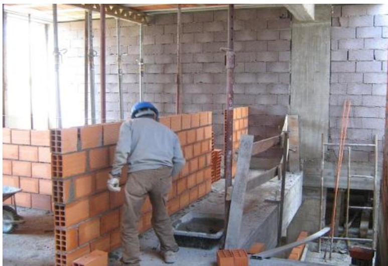
**Figura 28** - Paredes interiores alvenaria tijolo cerâmico furado (Afloret, 2015)
