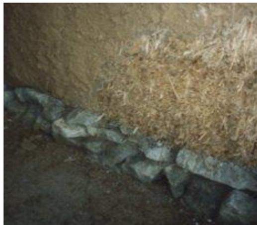
**Figura 25** - Parede de taipa com base em alvenaria de pedra (Fazer.es.no.sapo.pt, 2015)
