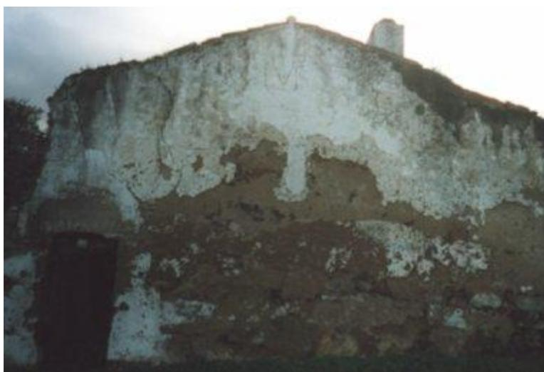
**Figura 26** - Parede de taipa revestida por cal (Fazer.es.no.sapo.pt, 2015)
