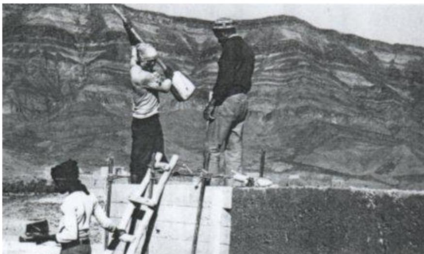
**Figura 23** - Construção de uma parede de taipa [fazeres.no.sapo.pt, 2015]
