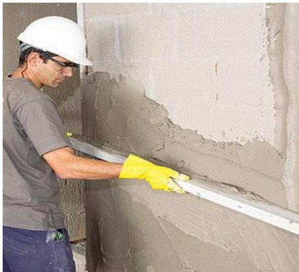
**Figura 30** - Parede interior alvenaria rebocada (Pedreiro, 2015)
