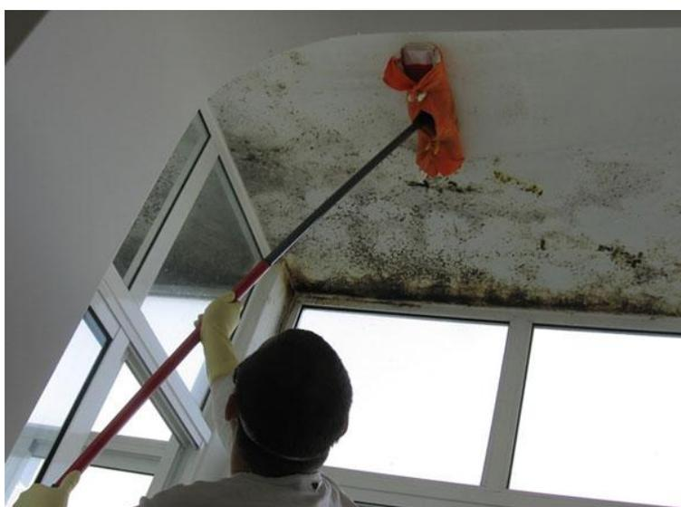
Figura 34 - Humidade condensação em tectos (Casadas.veudanoiva, 2015)
