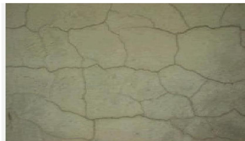
**Figura 38** - Fenómeno de retracção do revestimento (Arquiteturacuriosa, 2015)
