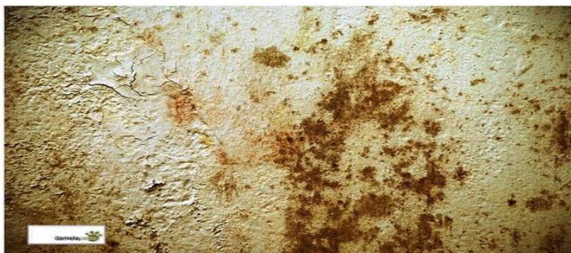
**Figura 37** – Salitre (eflorescência) em paredes (Construmatica, 2015)
