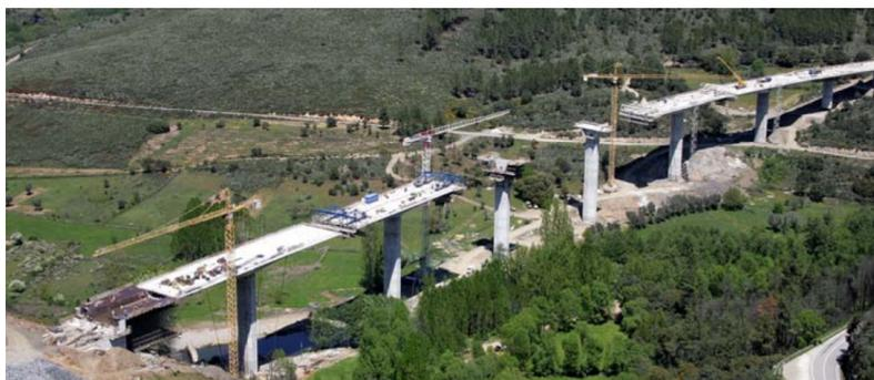
(c) Execução do tabuleiro em consola sobre os pilares P2 e P5
