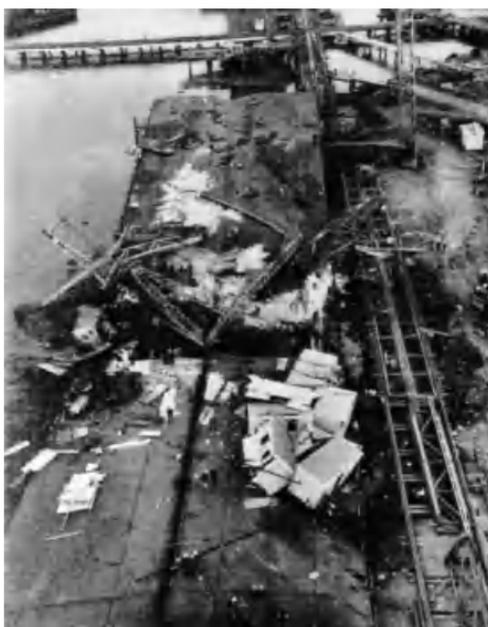
**Figura 3.13** Esquemas e fotografias do colapso da West Gate Bridge (Åkesson, 2008).
