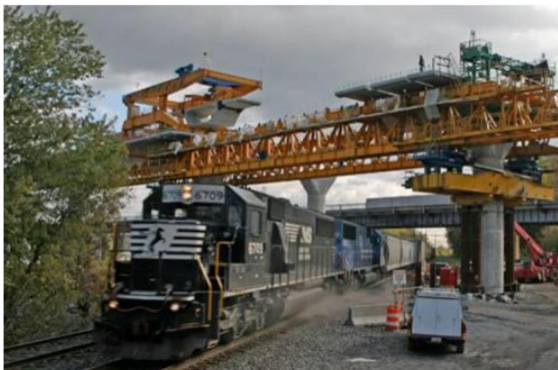
**Figura 2.9** Construção tramo a tramo com recurso a lançaadeira inferior (de Sousa, 2013).
