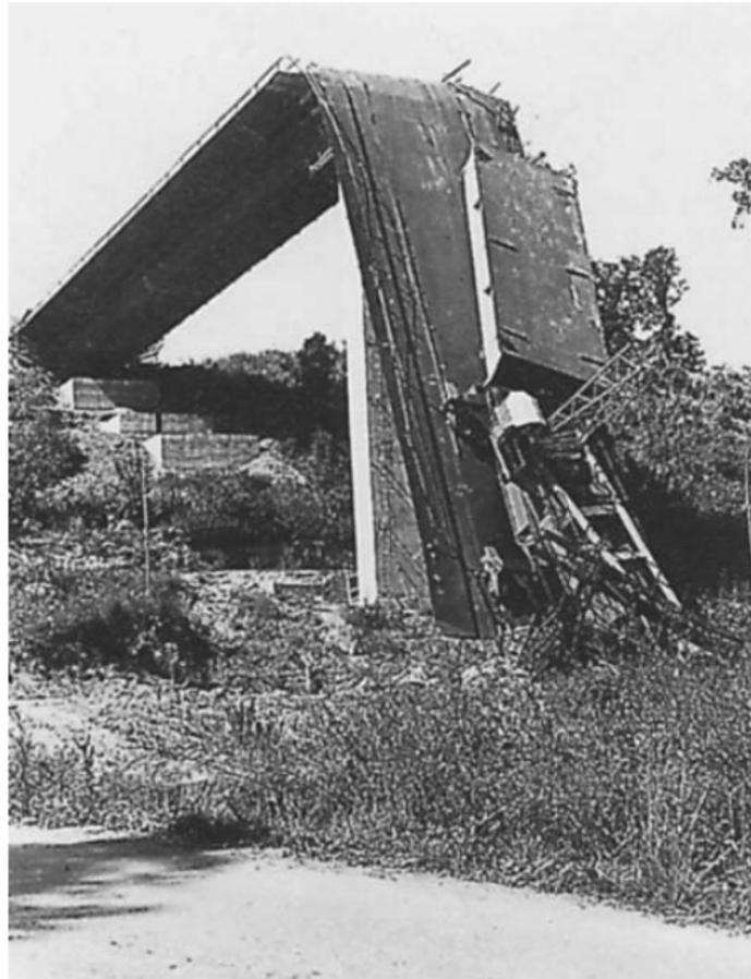
**Figura 3.17** Colapso da ponte de Zeulenroda (Åkesson, 2008).
