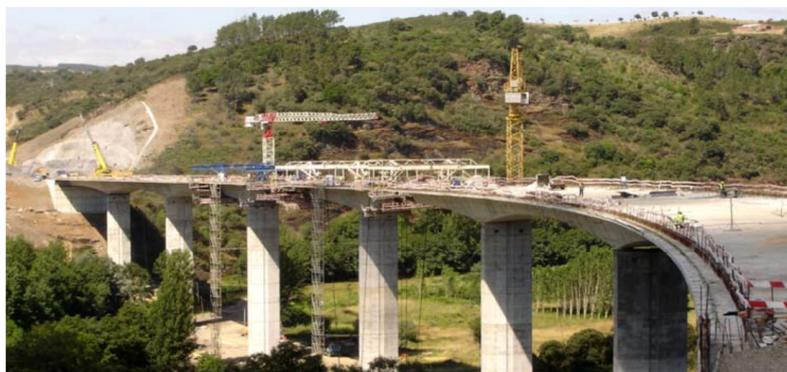
(d) Execução do tabuleiro em consola sobre os pilares P3 e P4 e fecho central
