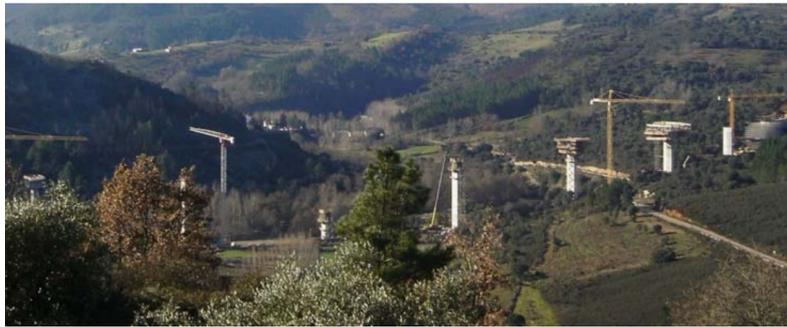
(a) Início da construção do tabuleiro sobre o pilar P6 e tramo 9
