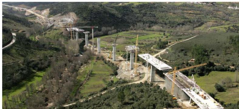
(b) Execução do tabuleiro em consola sobre os pilares P1 e P6
