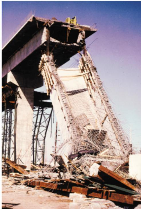
**Figura 3.1** Colapso de uma ponte devido ao deficiente escoramento temporário (Popovic and Nugent, 2001).
