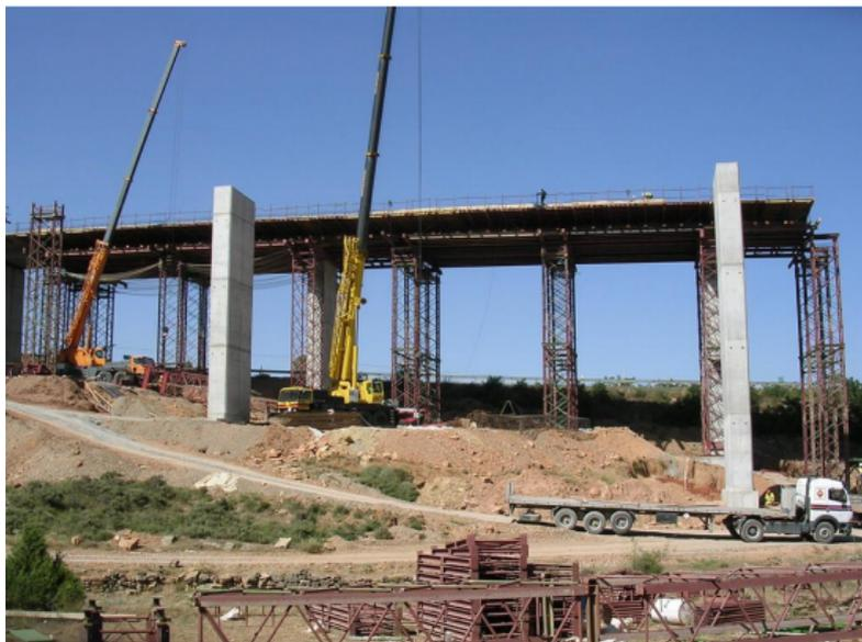
**Figura 2.4** Estrutura composta por torres e asas (Alves, 2009).
