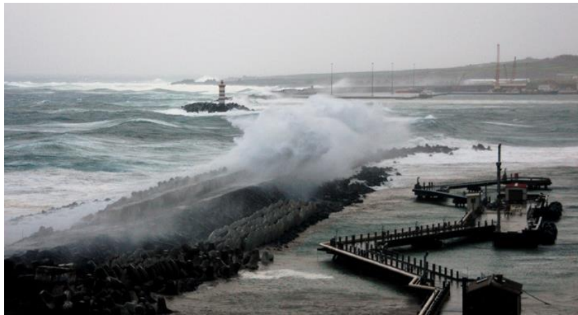
Figura 2.2 – Ocorrência do fenómeno de galgamento no porto da Praia da Vitória, em fevereiro de 2005 [2].
