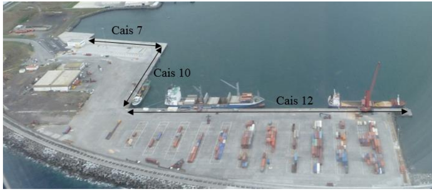
Figura 4.10 – Porto comercial da Praia da Vitória (Neves et al., 2012).
