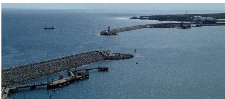
Figura 4.9 – Quebra-mares norte e sul do porto da Praia da Vitória [12].
