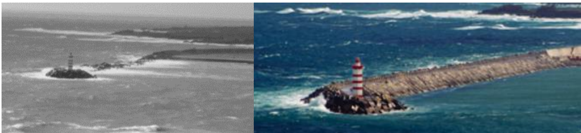
Figura 4.24 – Diferença entre antes e após da reconstrução do quebra-mar sul do porto da Praia da Vitória [19].
