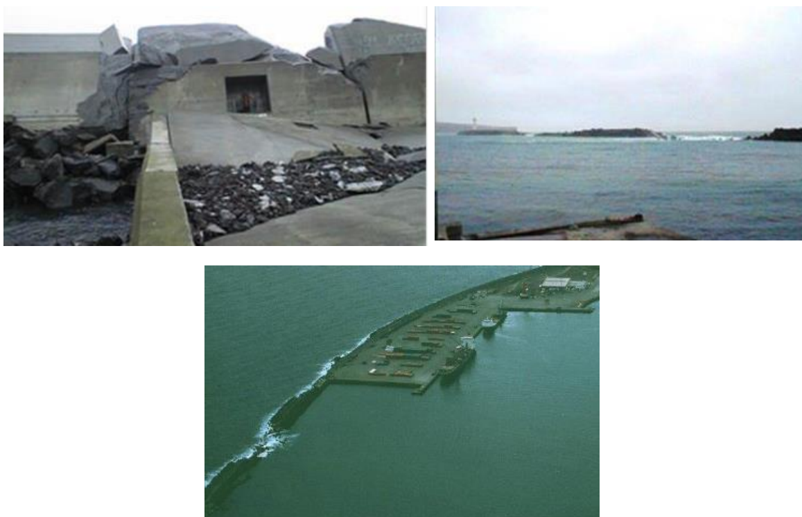
Figura 4.21 – Destruição do quebra-mar sul do porto da Praia da Vitória, em dezembro de 2001 (Silva, 2011).
