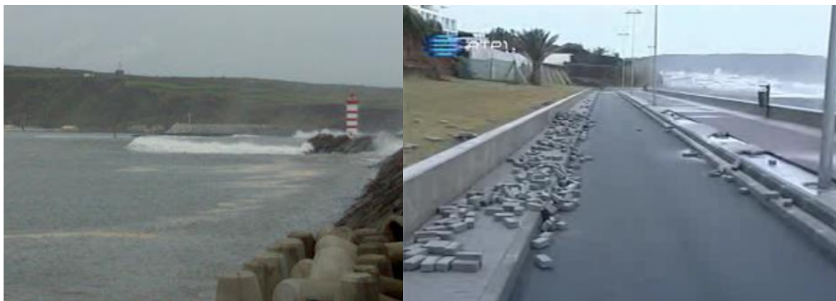
Figura 4.27 – Galgamentos sobre o quebra-mar sul e defesa frontal da Praia da Vitória, em janeiro de 2010 [22].
