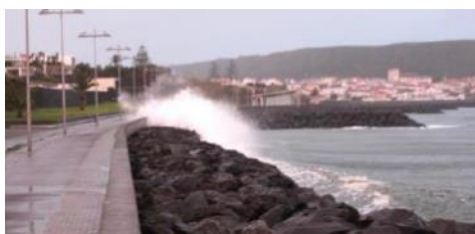
Figura 4.31 – Galgamentos na defesa frontal da baía da Praia da Vitória, em dezembro de 2015.
