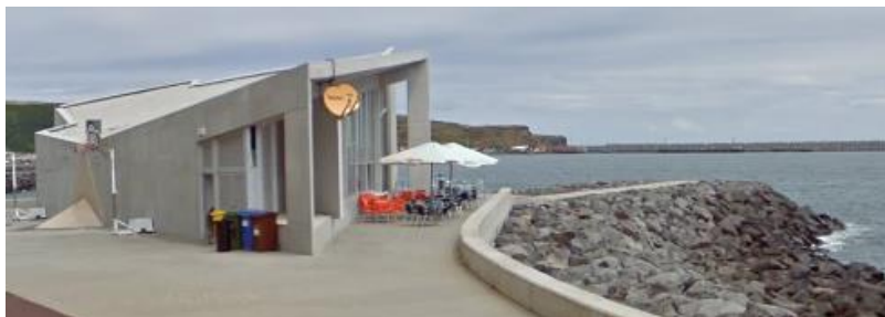
Figura 4.19 – Bar situado no enraizamento do esporão 3 [17].
