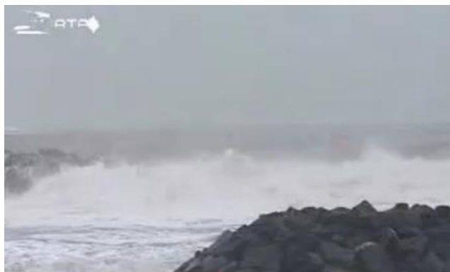
Figura 4.26 – Galgamentos no quebra-mar sul do porto da Praia da Vitória, em dezembro de 2009 [21].
