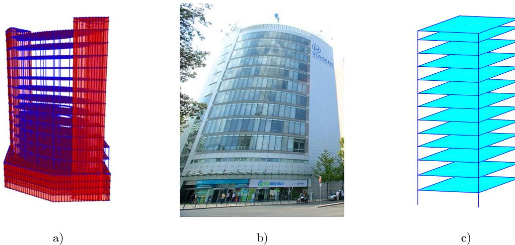
**Figura 1.4** - Estudo de caso: a) Modelo numérico em elementos finitos desenvolvido no programa SAP2000; b) Edifício de 16 pisos; e c) Modelo de suporte à análise experimental desenvolvido em MATLAB.
