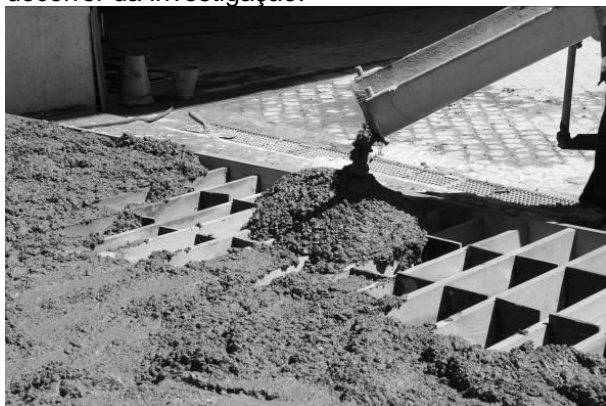
Figura 1 - Pormenor da betonagem dos prismas a triturar
