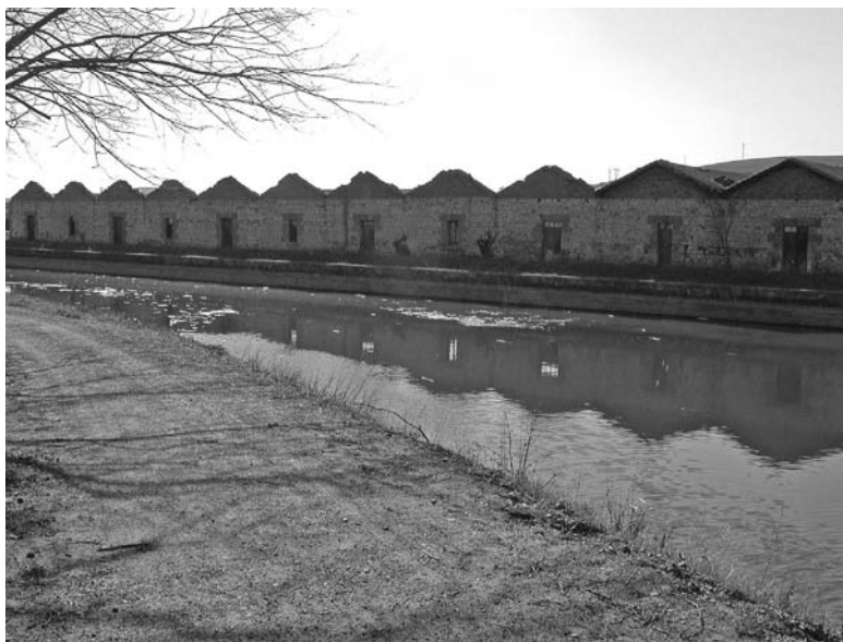
Dársena de Alar del Rey (Palencia). Visión de la fachada seriada que conforman los antiguos almacenes
