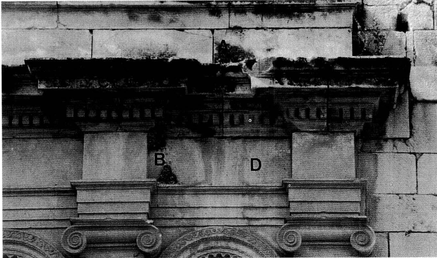
A la foto es poden observar les formes d'alteració següents: patina de brutícia (A), excrements d'aus (B), crosta negra (C) i eflorescència (D).
