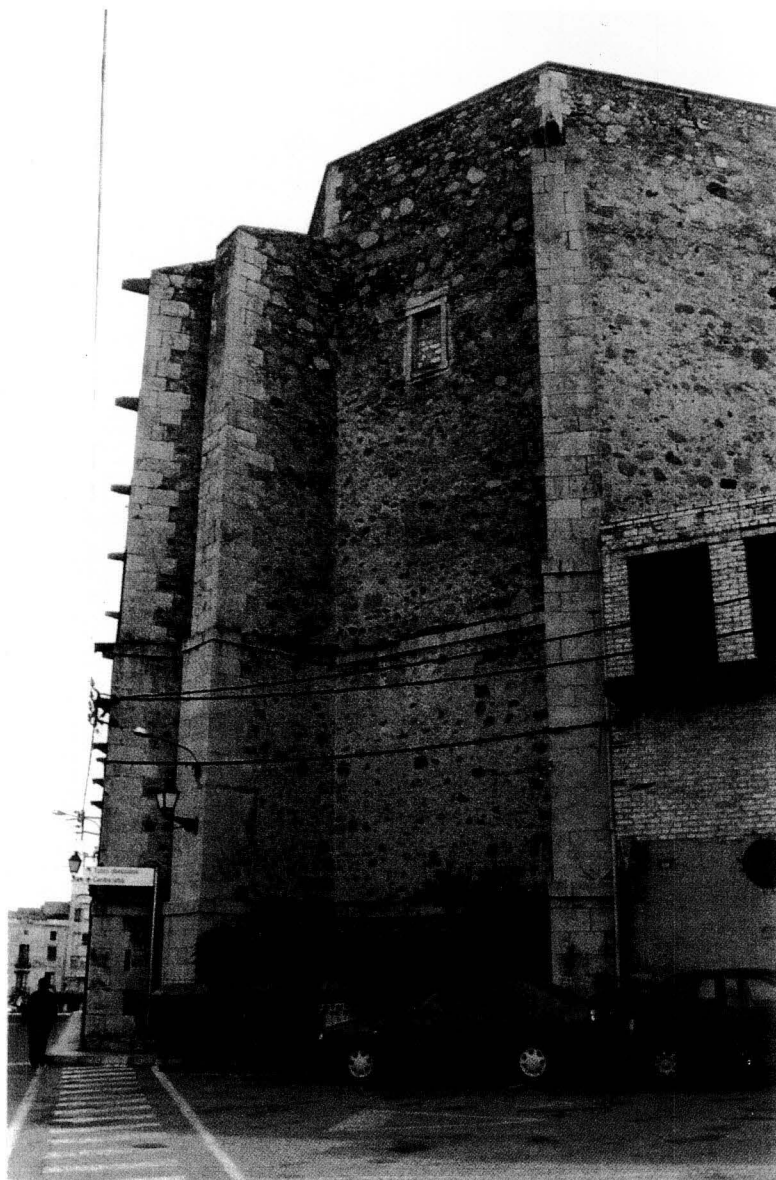
La foto ens mostra la finestra de l'absis tapiada que no permet l'entrada de la llum a l'interior de l'església, deixant l'altar molt fosc.
