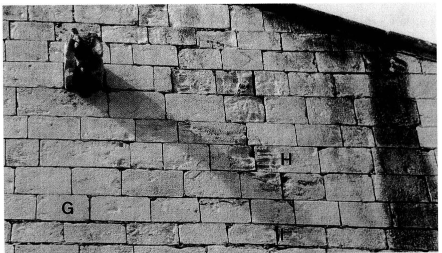
També en aquesta imatge s'aprecien les alteracions següents: lixiviació (G), picadura / alvèol / acanaladura (H) i badadura (I).
