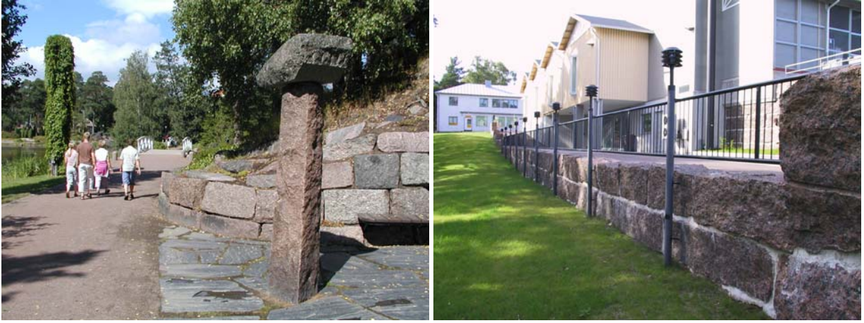
Kuva 19. Sivukivet ovat esteettisiä muureina, monumenttikivinä sekä kauniin värisinä murskeina. Oikea kuva: Palin Granit Oy.
