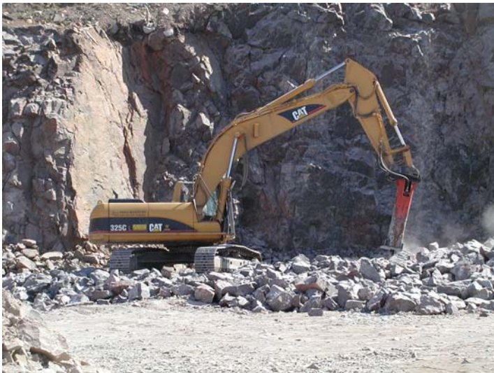
Kuva 12. Kivien rikotusta kalliomurskelouhoksella
