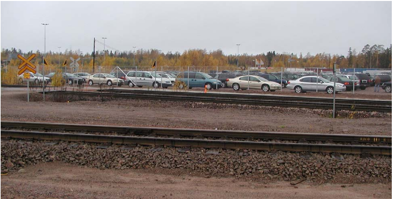
Kuva 18. Kotkan satama-alueen autokenttä ja raiteiden alusrakenteet on rakennettu paikallisista kiviaineksista, joita voidaan korvata tulevaisuudessa yhä enemmän sivukivillä.
