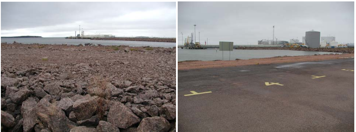
Kuva 17. Haminan satama. Sivukiviä voidaan hyödyntää satamarakentamisessa mm. täyttöihin, pengerryksiin, aallonmurtajiin ja asfaltin kiviaineksena.
