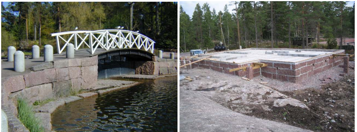
Kuva 20. Sivukivet soveltuvat perinteisten siltojen perustuskiviksi (Sapokan vesipuisto) sekä rakennusten perustuskiviksi (Kuva Kymen Granite Oy)
