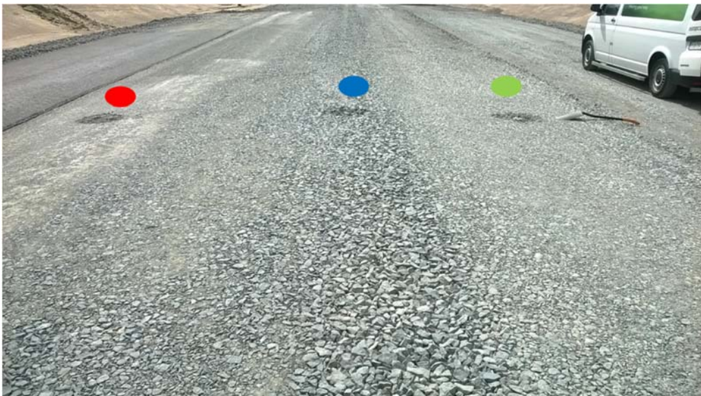
Kuva 9. Kantavan kerroksen näytteenotto lajittuneesta poikkileikkauksesta. Näytteet on otettu karkearakeiselta (sininen), hienorakeiselta (punainen) ja keskimääräiseltä (vihreä) näyttävältä pinnalta.
