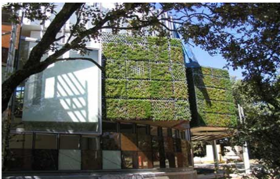
Il·lustració 47: Sistema Green Living Technologies a la dreta i sistema de panells modular a l'esquerra. Font:(Hildebrandt Gruppe, 2015)
