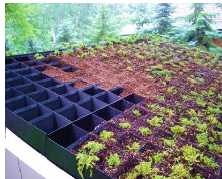
Il·lustració 47: Sistema Green Living Technologies a la dreta i sistema de panells modular a l'esquerra. Font:(Hildebrandt Gruppe, 2015)
