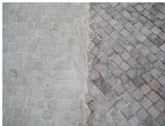
Plaza Muñoz de Almería. Detalle de pavimento reciclado de canteras locales. Proyecto: Ramón de Torres. Foto: Santiago Copado
