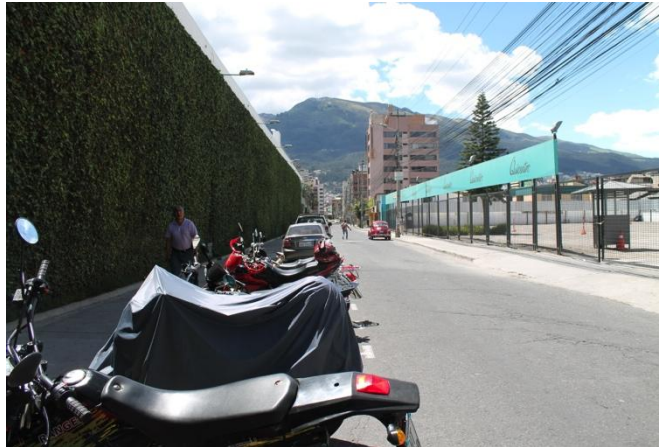
Figura 41. Fachada norte, ciega, del Quicentro. Fuente: Daniela Loaiza, 2016.
