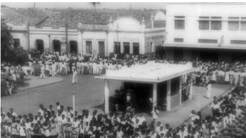
Figura 05: Vista do local de abastecimento de veículos (Helder Fontenele, sem data)
