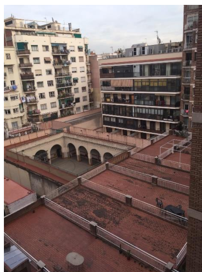
Figura 9. Foto edificios alrededor que proyectan sombra en la fachada trasera
