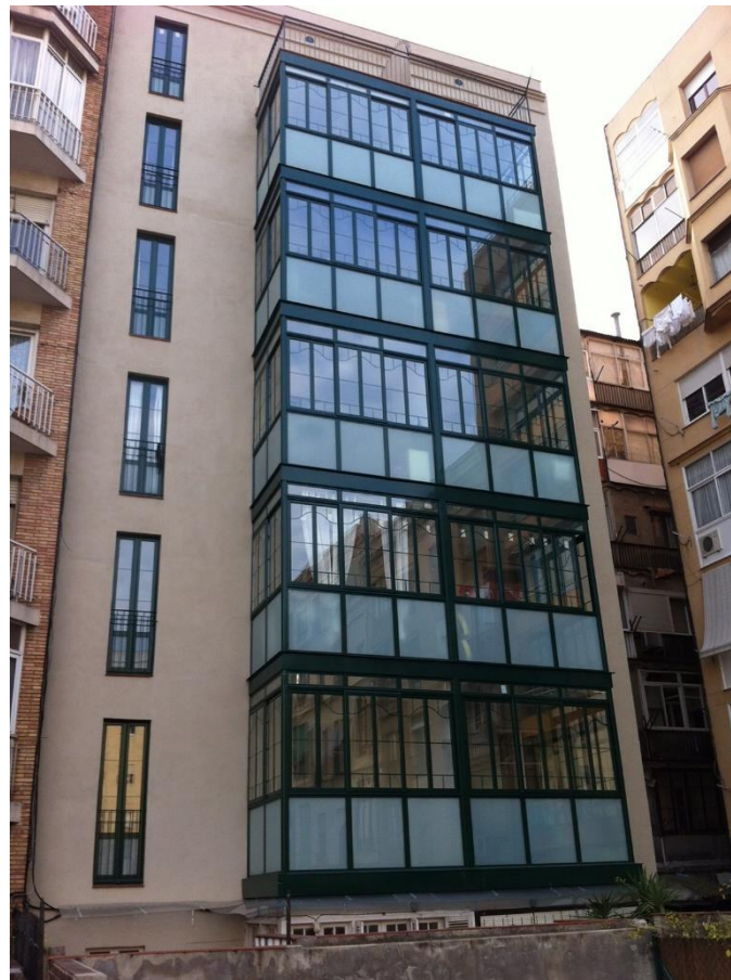
Figura 6. Foto fachada trasera
