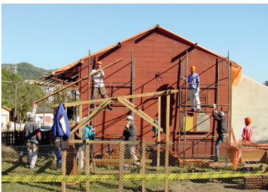
Cooperativa de Marcenaria em atividade de restauro das Casas Tipo E-CDARQ. Fonte: LIMA, 2008. Fotos: Gilson Lima, 2007
