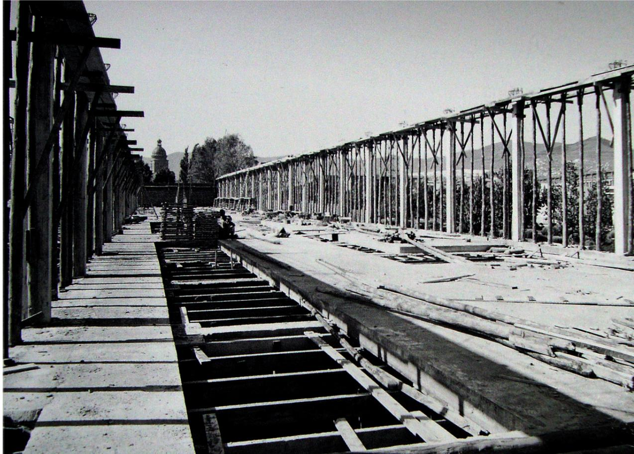
25. Trabajadores de la construcción de la fábrica ENMASA; al fondo, la Iglesia de Sant Andrés; 07 de octubre de 1955. La estructura portante en hormigón armado de ese edificio, hecha de forma tradicional, deja aparente la retícula de pilares que van a crear una fachada modular y continua.
