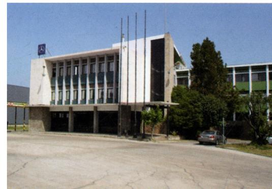
32. Imagen más reciente de la torre de dirección. Terradas ha utilizado colores na composición de las fachadas, junto con las ventanas y los bloques de vidrio. Los paños de piedra marcan la base del edificio y la empeña de la escalera.
