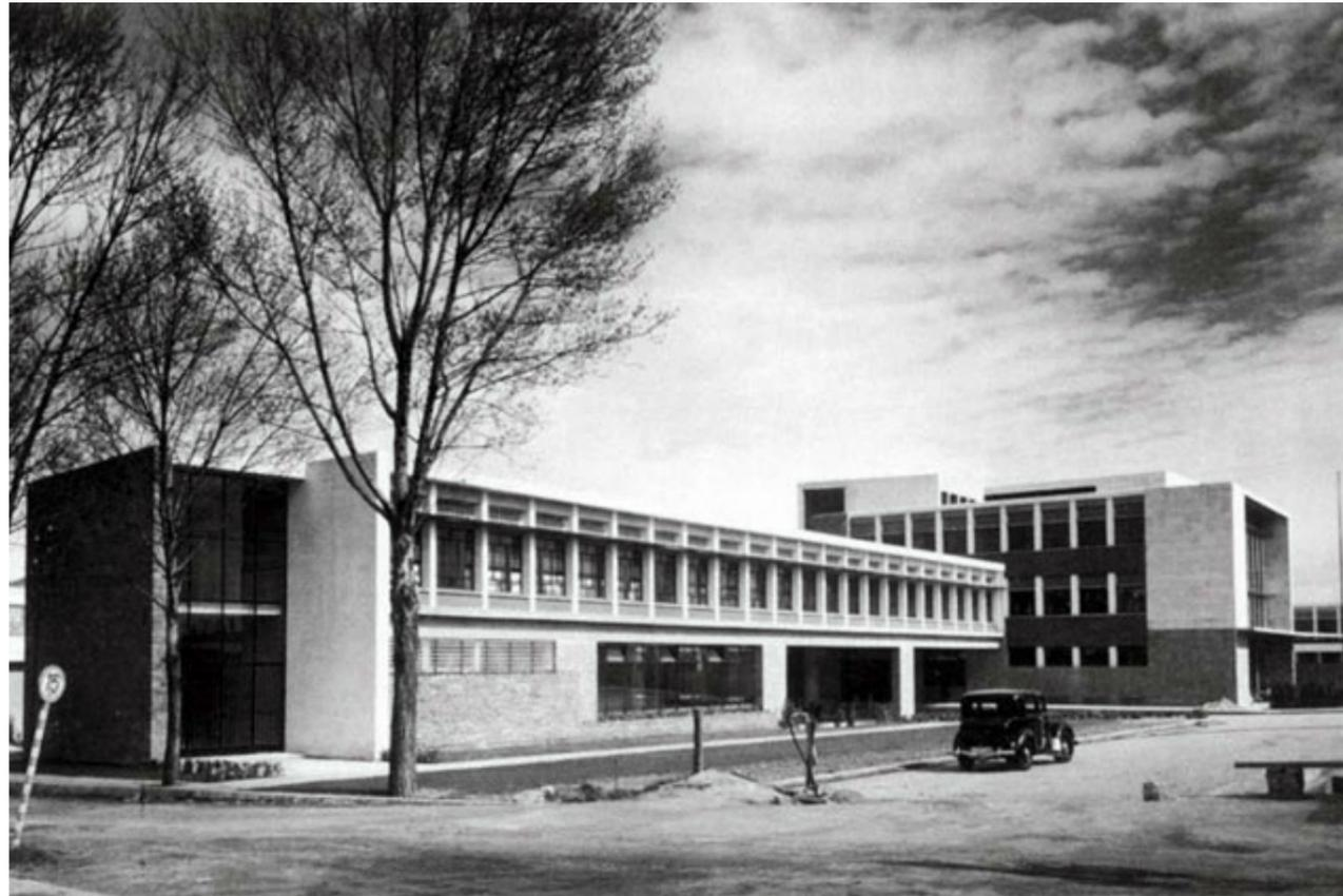
31. Alzado sur principal: edificio-puente y lateral leste del edificio de dirección. Los giros y los testeros de los volúmenes requieren una especial atención y se aplacan algunos planos con piedra y grasoite para contrapuntar el espacio.
