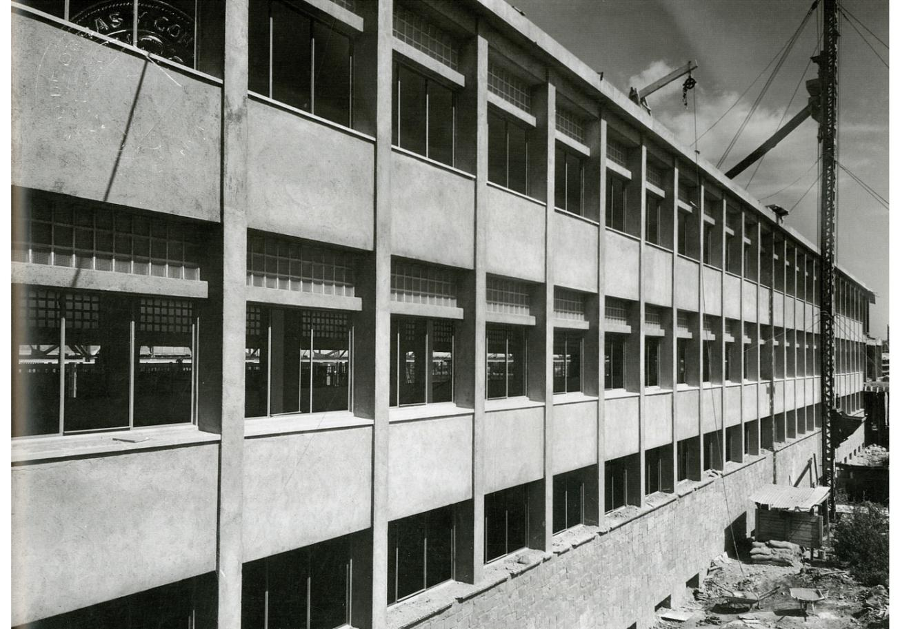
26. O Oficinas en construcción, en estructura portante de hormigón armado. Septiembre de 1956. Aquí, Terradas incorpora tres consideraciones importantes para la arquitectura fabril de los años 50: el radical abandono de la condición portante de la fachada, la transparencia, y la luminosidad natural, alcanzadas con la incorporación de bloques de vidrio en composición con las amplias ventanas de la fachada.
