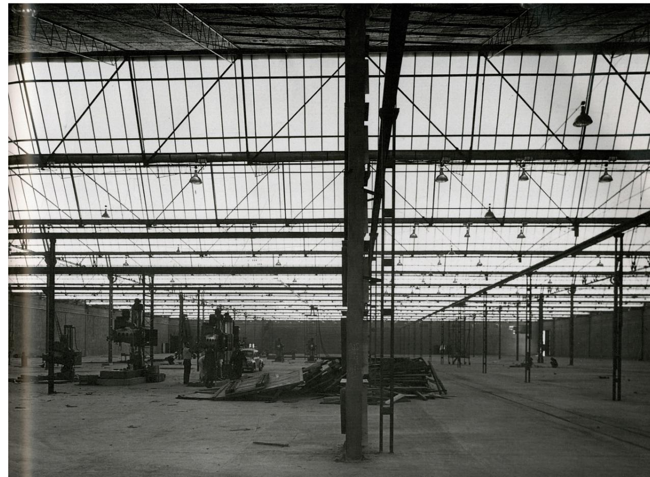
28. Interior de la nave de montaje. 05 de julio de 1960. Luminosidad es la palabra para adjetivar esos nuevos espacios. La continuidad de las cubiertas de las naves era interrumpida por entradas de luz natural en los locales destinados a la producción y el montaje. El vacío predomina sobre el lleno. El espacio es libre y diáfano.
