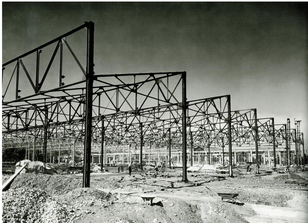
27. Estructuras metálicas de las naves de producción de motores de aviación. 07 de octubre de 1955. La cubierta con dientes de sierra se apoya sobre una ligera retícula de pilares metálicos. La estructura es pre-moldada, en contraste con la construcción casi artesanal de las estructuras de hormigón.
