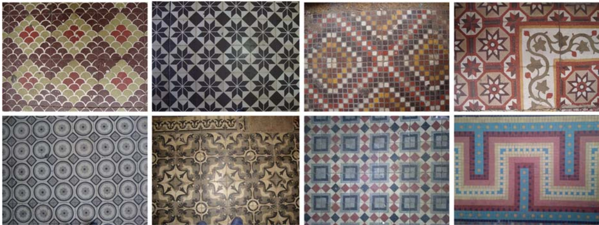
Figura 7 Muestrario de pavimentos cerámicos y de mosaico hidráulico en los zaguanes de escalera
