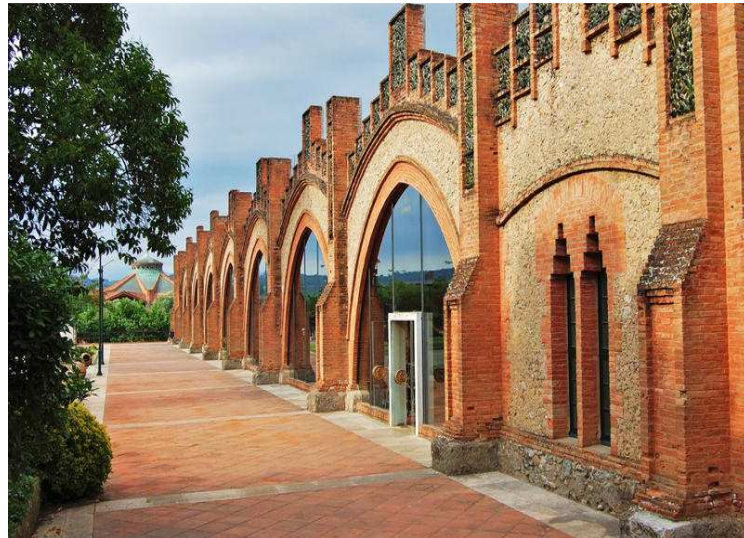
Figura 1.- Façana porxo de premses
