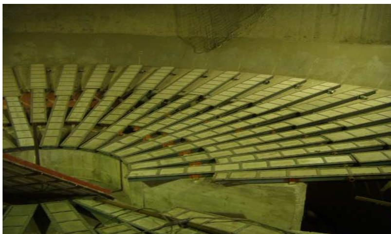
**Imagen 13.** Diseño de interior de silos con parrilla de fluidificación. Fuente: Elaboración propia.
