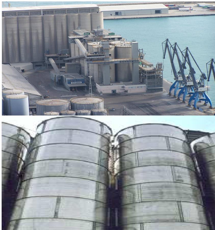
**Imagen 11.** Silos de hormigón armado y metálico. Fuente: Elaboración propia.
