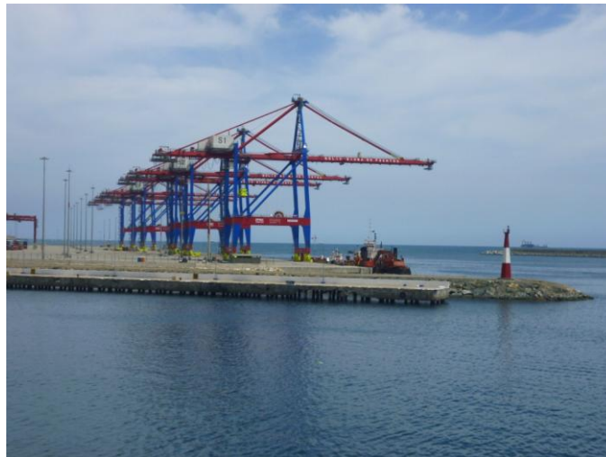
Figura 9. Grúas Gantry de acuerdo al Plan de Expansión del puerto de La Guaira Fuente: (Ramírez Arana, 2014)
