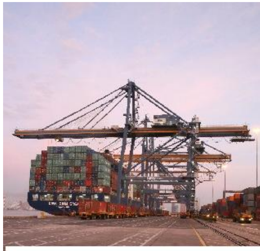
Figura 12. Grúas Gantry en el puerto de Cartagena Fuente: (Sociedad Portuaria Regional de Cartagena, S.A., 2015)
