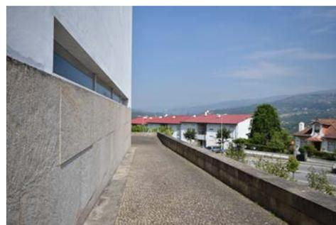
Figuras 140 a 142 (izquierda, superior y centro derecha): Ventana horizontal de 16 metros de longitud y 50 cm de altura, colocada a 1 metro de separación del suelo. Su longitud determina la dimensión, medida a lo largo, del espacio destinado a los asientos de los fieles para que estos puedan contemplar el paisaje natural y construido del valle del Duero.
