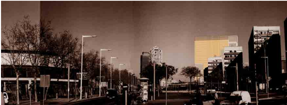
Render y maqueta de la propuesta. Fotomontaje desde la plaza Pau Vila.
