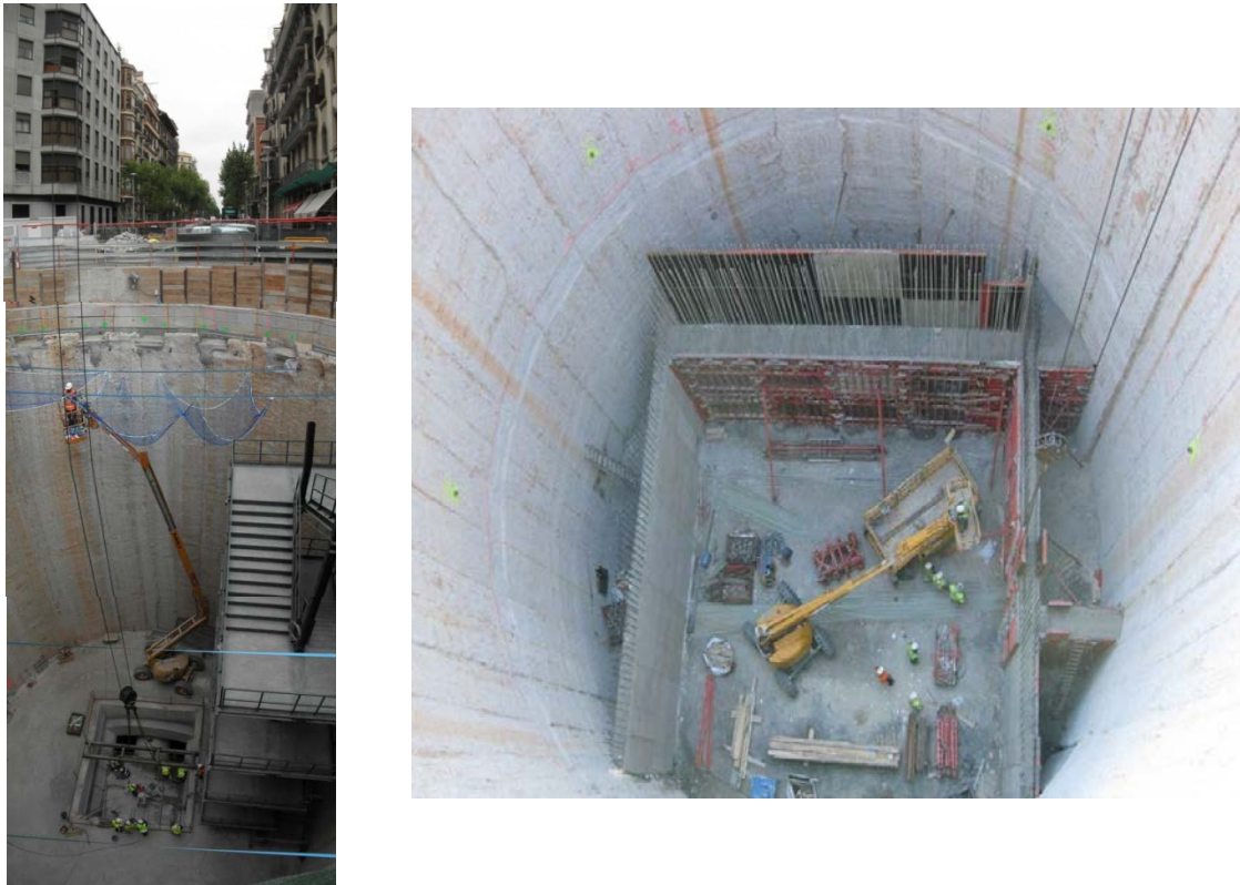
Figura 8.2. Pozo de Bruc-Provenza ejecutado mediante pantallas con hidrofresa.
