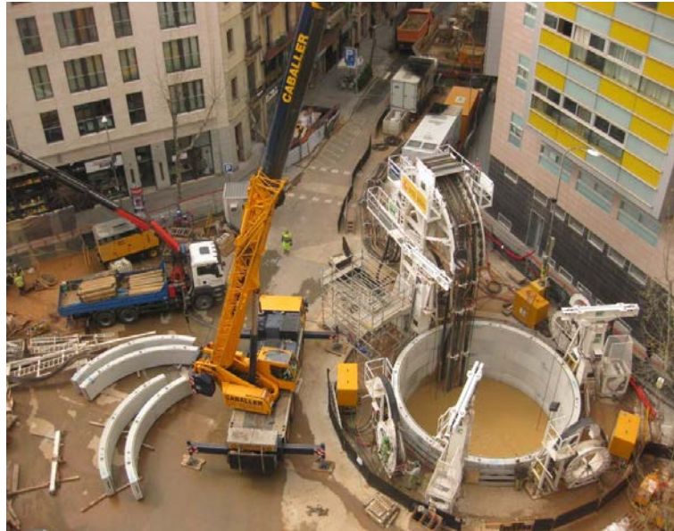
Figura 8.3. Pozo de Enric Granados-Provenza ejecutado mediante tuneladora vertical.
