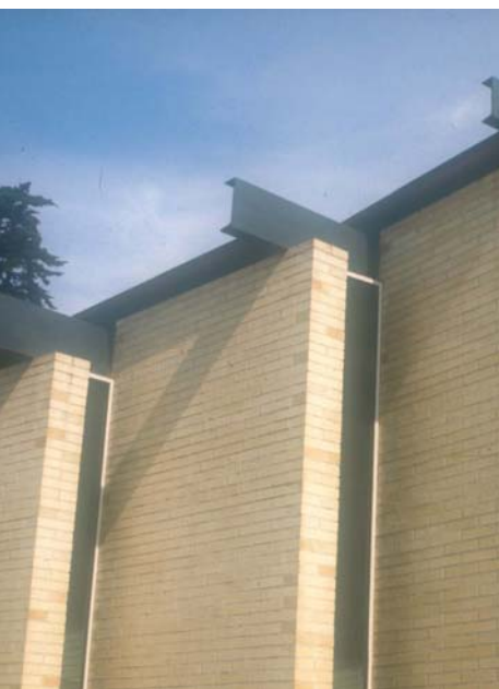
_Particolare del nodo tettonico tra i setti e gli elementi della copertura.
