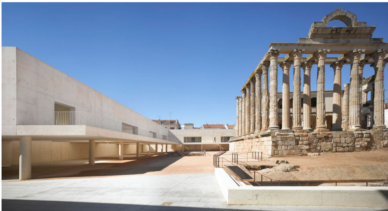
_La piazza del Tempio di Diana dopo la realizzazione dell'intervento.
