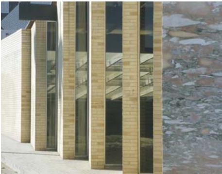
_Particolare delle feritoie tra i setti murari.
