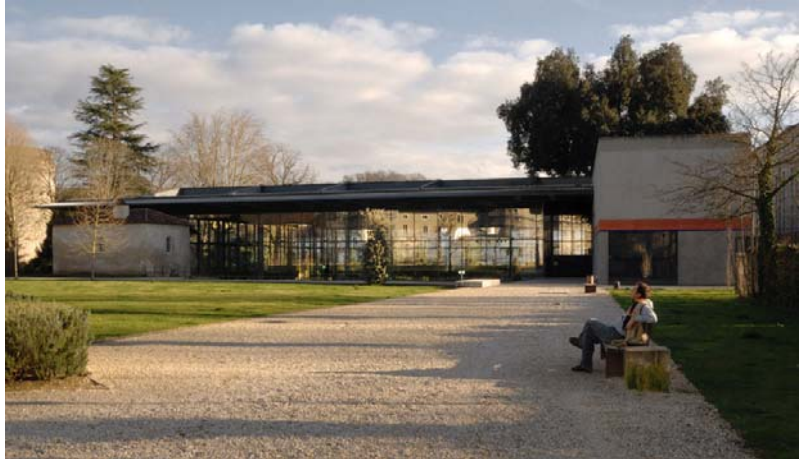
L'edificio del Museo visto dall'esterno.
