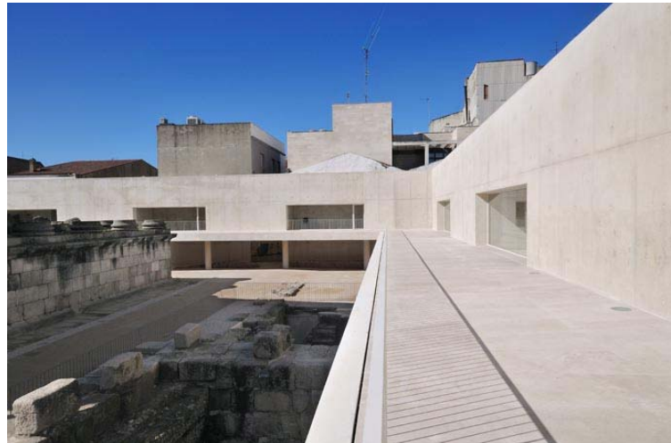
_La piattaforma-camminamento. Sulla sinistra il basamento del Tempio. Al fondo, gli edifici con le pareti cieche che prima dell'intervento si affacciavano sulla piazza.
