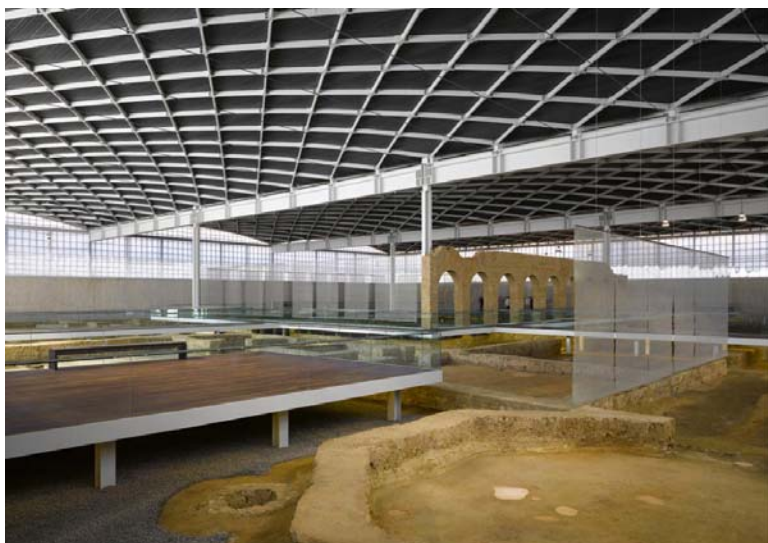
_Veduta interna dell'area archeologica con la grande copertura.
