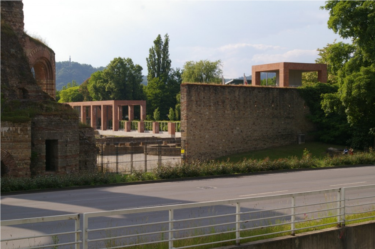
_La testata del nuovo volume d'accesso.
