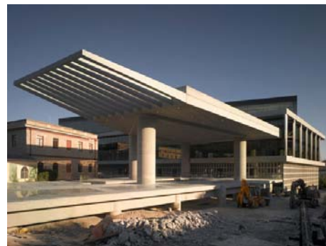
_La pensilina d’ingresso e di protezione delle rovine dell’area esterna al Museo.
