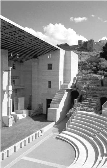
_Particolare del nodo Est tra il nuovo fronte scenico e la cavea. Sullo sfondo, il Castello di Sagunto.
