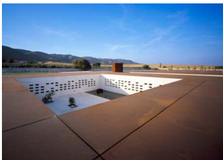
_La copertura in corrispondenza del grande patio centrale.
