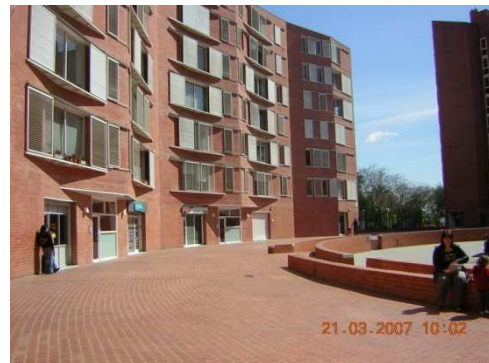
Imagen. 5.66. Circulación peatonal C, fachada Sur.
