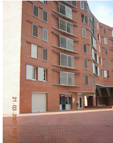
Imagen. 5.42. Circulación peatonal B, frente a la fachada Sureste. Trayecto Dos, Nova Icària.
