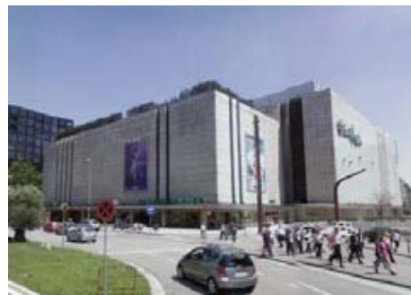
Imagen 43, 44, 45 Tipologías contenedores PV (Fuente: F)
