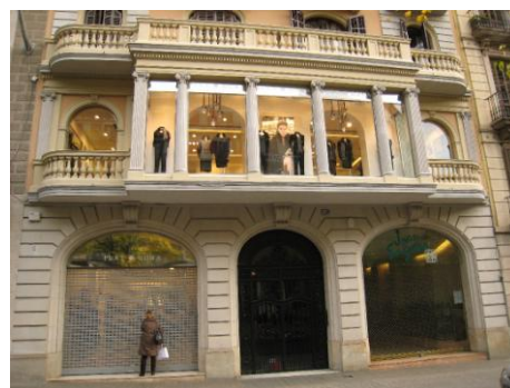
Imagen 31. Locales en planta primera de edificios en la Rambla Catalunya (Fuente: F)
