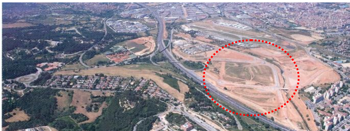
Imagen 26. Vista general zona de emplazamiento nuevo IKEA Sabadell (Barcelona), cuya superficie de venta es de 40.000m 2 .
