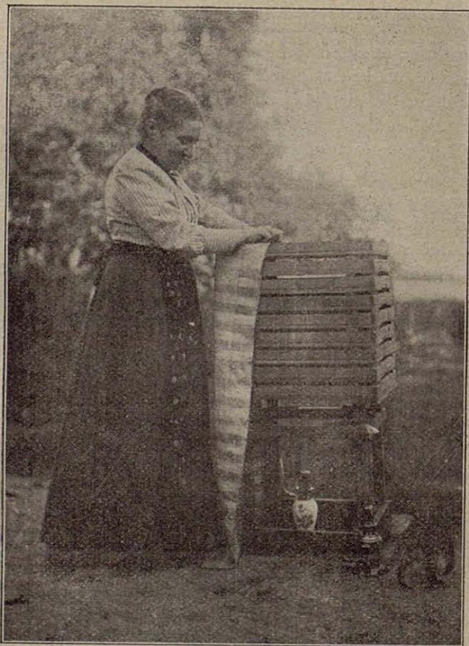
Fig. 38. — Manière d'installer une étuve en disposant sur un tabouret renversé des claies superposées. Le tout est entouré d'une toile. Cette installation doit être ensuite transportée dans une pièce fermée.
