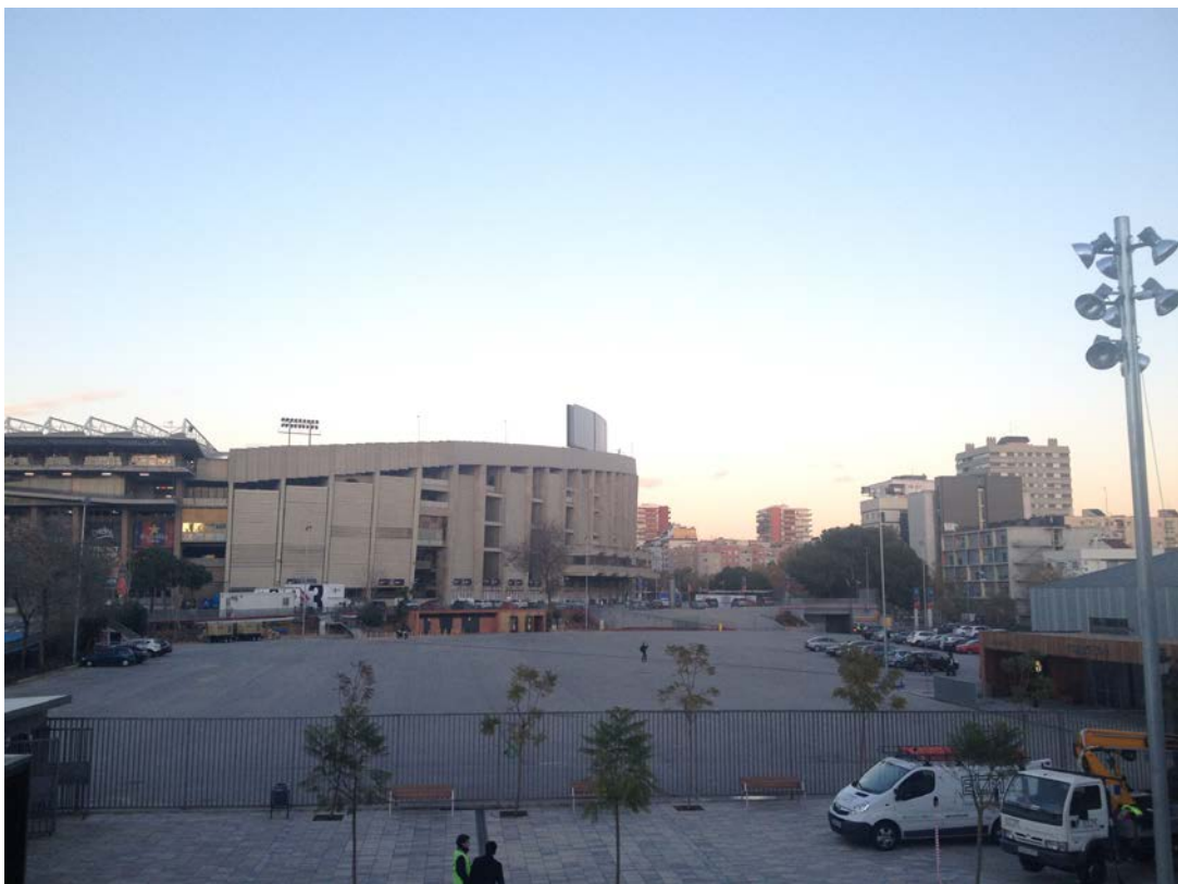
Imatge 10: Interior Complex Camp Nou. Vistes des de plataforma. Font: Jordi Figols. (F10)
