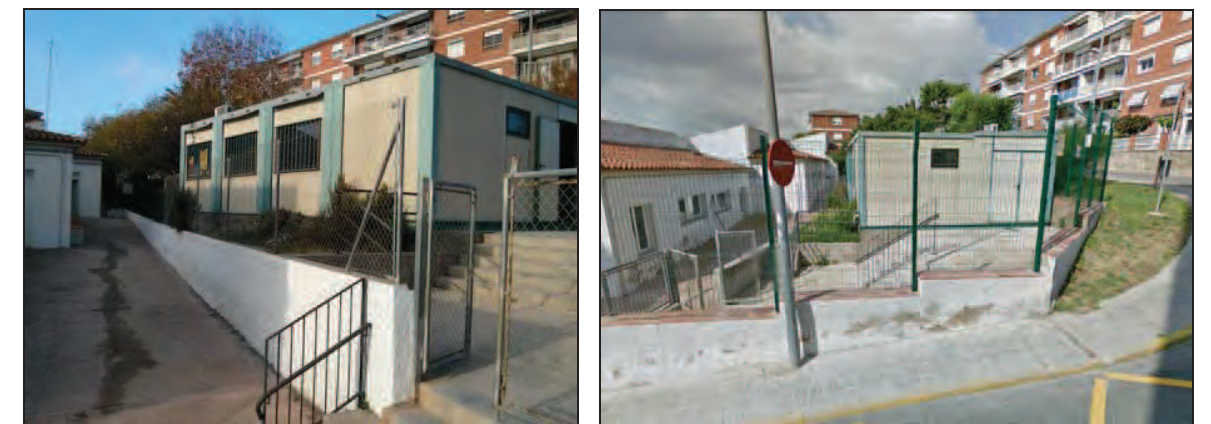
Vista general de la zona on es realitza l'ampliació.
