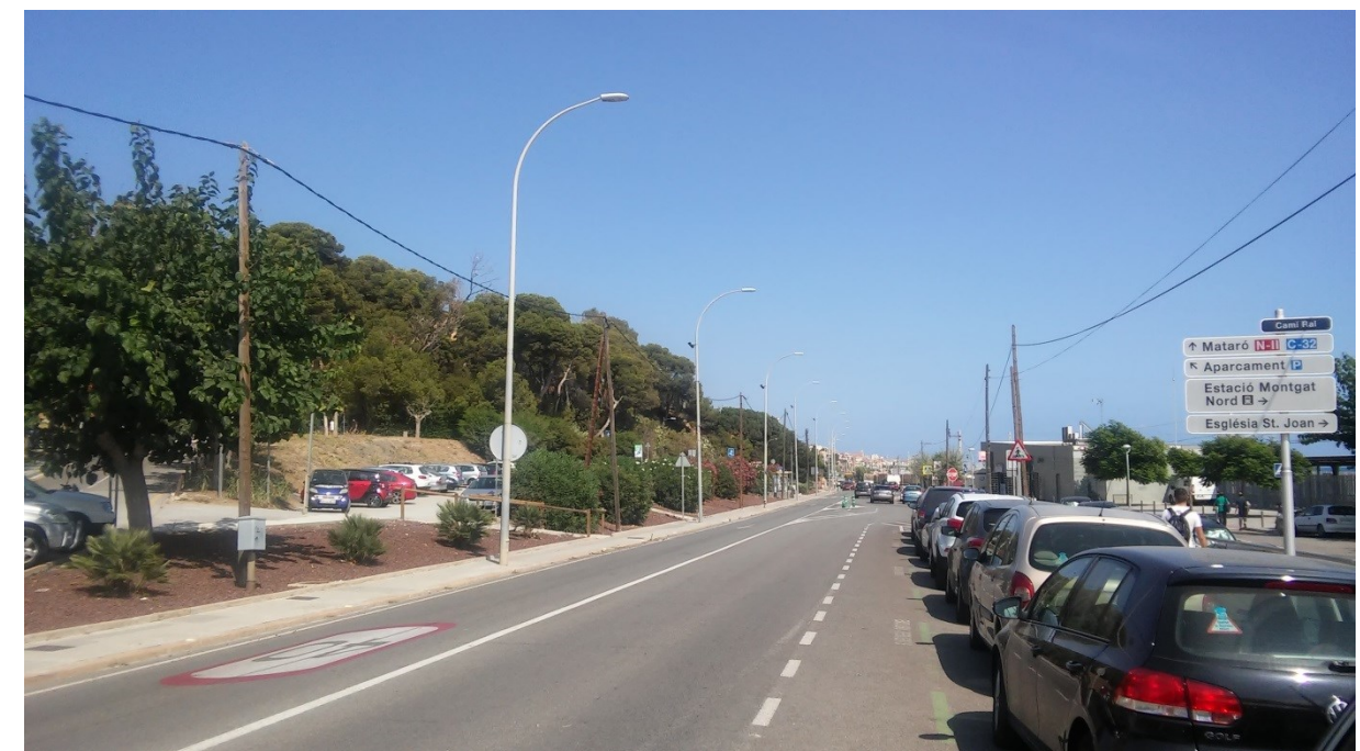
Il·lustració 16. Vista general de l'emplaçament de la passarel·la número 2
