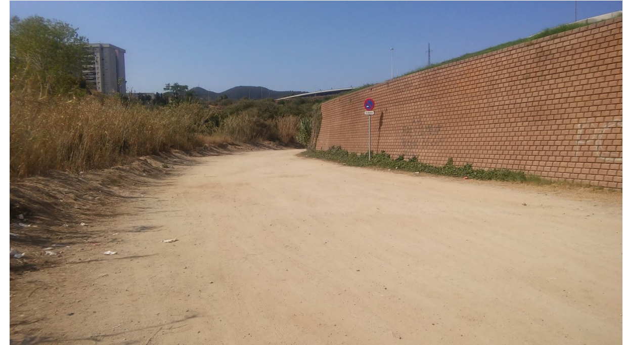
II·lustració 3. Localització de la rampa oest de l'edifici número 1
