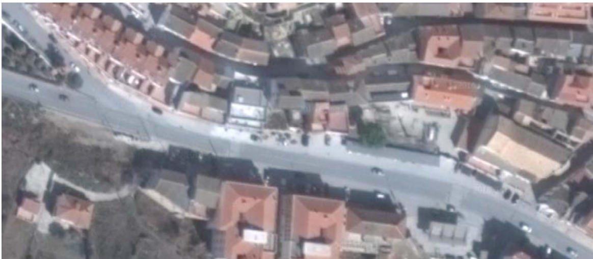
Tramo 2 Tramo central 1 norte-oeste
