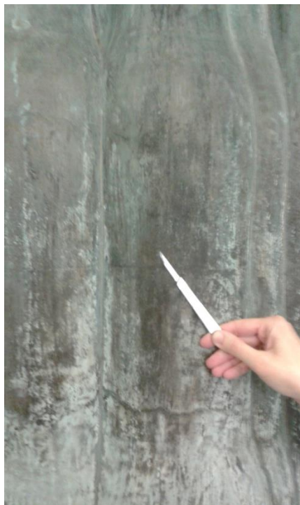
Εικόνα 109 Επικαθίσεις- προϊόντα διάβρωσης μαύρου χρώματος, Δείγμα 7
