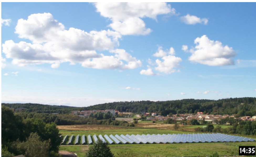
Εικόνα 5.1 Το σύστημα ηλιακής τηλεθέρμανσης της πόλης Kungälv στη Σουηδία
