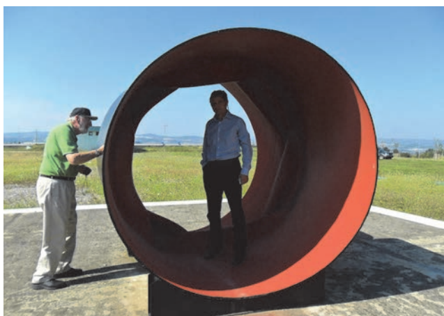
Slika 1. Detalj cijevi s borama u Kullaru, u Izmiru, oštećene tijekom potresa Kocaeli (1999.)
