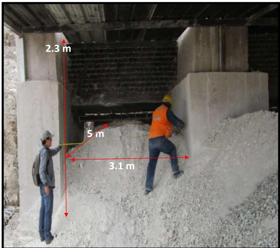
Foto 7: Medidas del Cajón del horno 1 y 2.
